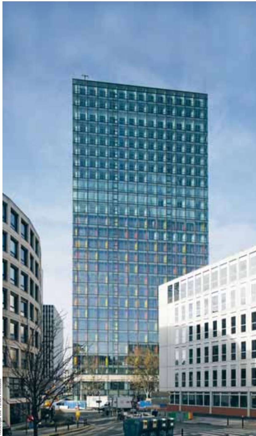
La tour Franklin (BNP Paribas Immobilier), à Montreuil, est l'objet d'une opération de rénovation.
