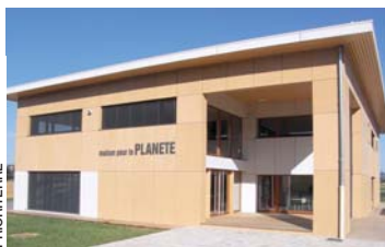
Le siège de Prioriterre cumule isolation sur six faces, pompe à chaleur, solaire...
