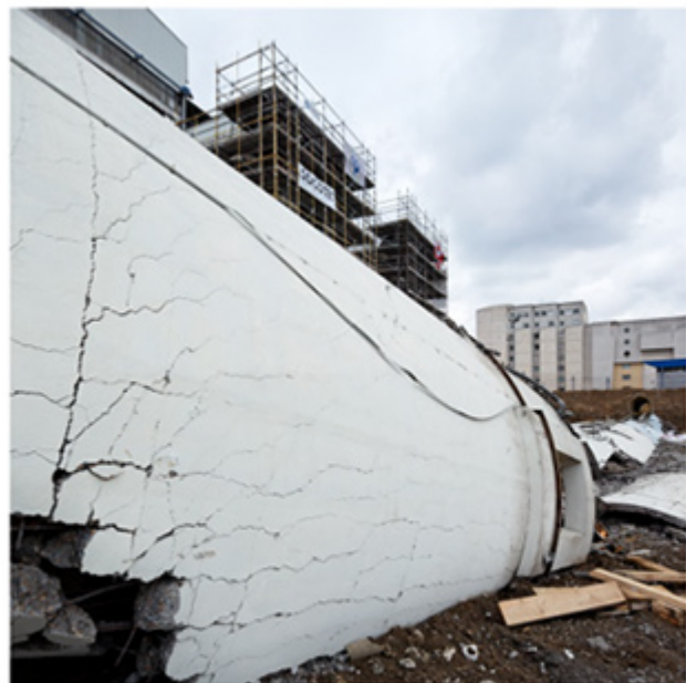
Démolition de l'usine d'incinération des déchets ménagers d'Issy-Les-Moulineaux
